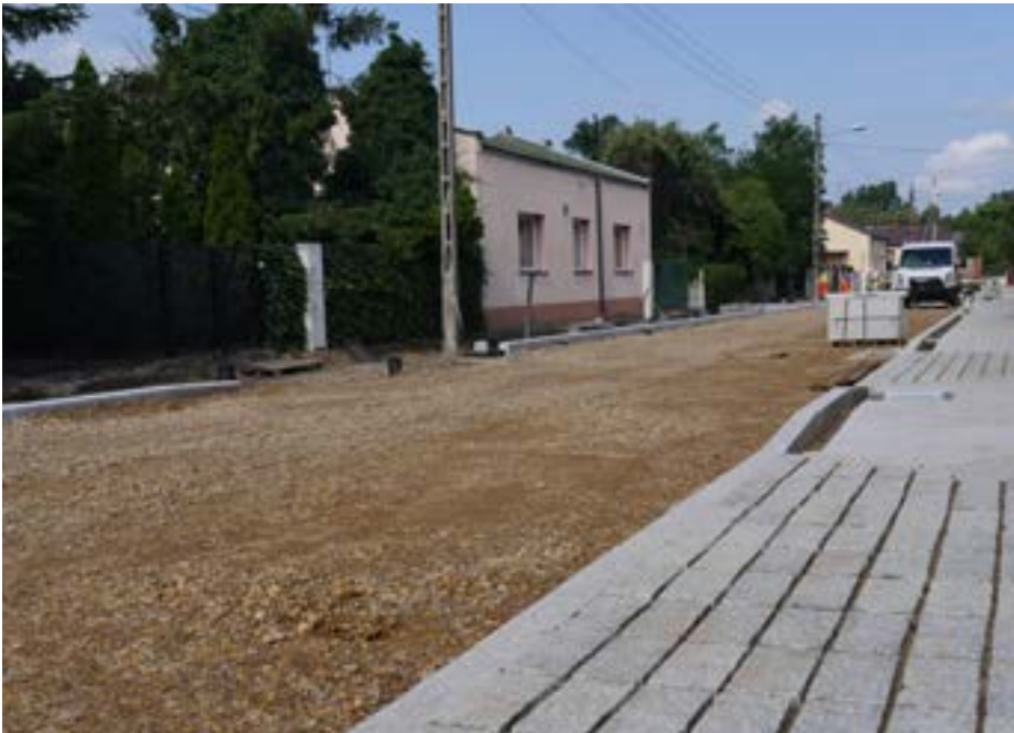
Prace nad modernizacją ulicy Żeromskiego w Szczercowie
